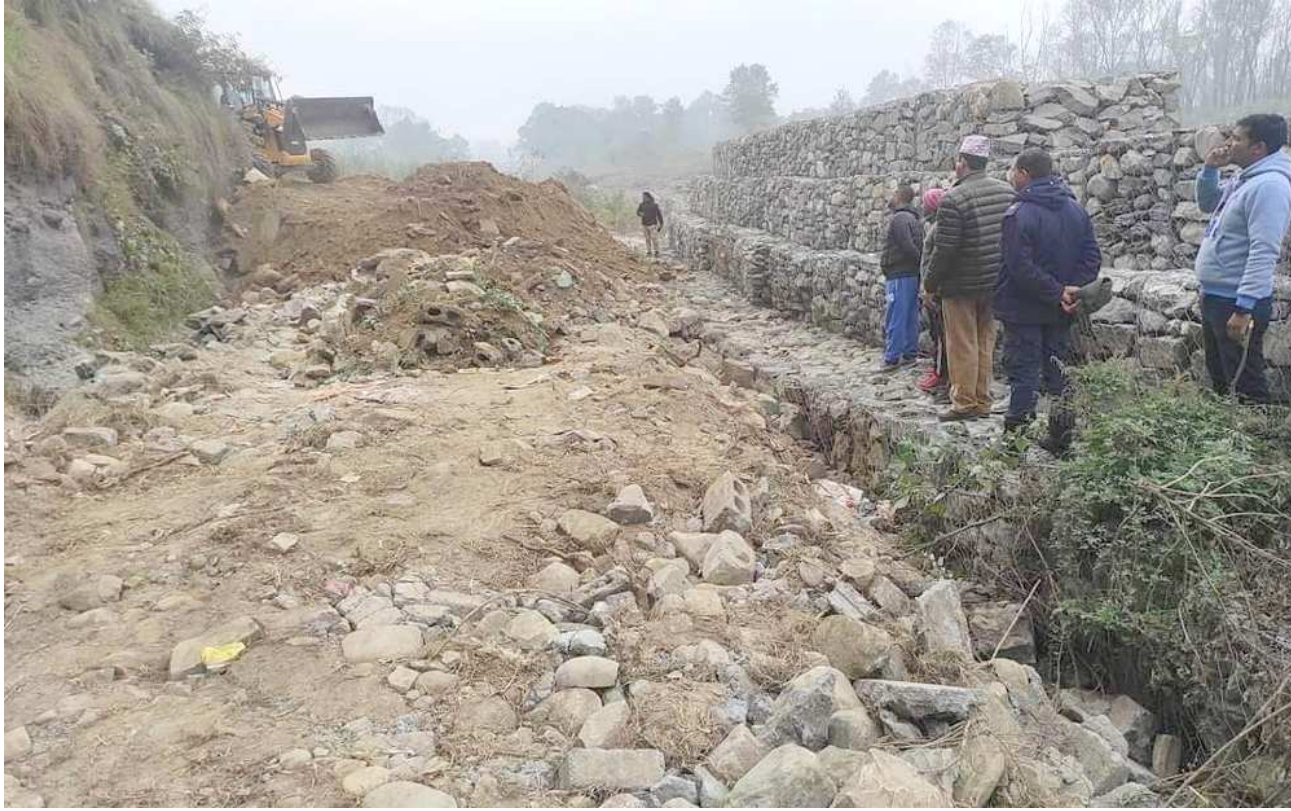
वैकल्पिक मार्गको निर्माण : तनहुँको शुक्लागण्डकी नगरपालिकाको बजार सरसफाईबाट निस्केको सामग्री नगरपालिकाको वडा नं. ४ नयाँपुलदेखि गाछेपानी जाने सडकखण्डमा प्रयोग गरी वैकल्पिक मार्ग निर्माण गरिदै । नगरपालिकाले प्राविधिक लगत इस्टिमेट बमोजिम वडा नं. ८, ९, १०, ११, १२ लगायतका स्थानबाट आउने सवारी साधनको वैकल्पिक मार्गको प्रयोग गर्ने र सवारी चापकम गर्न मद्दत पुग्ने नगरप्रमुख कृष्णराज पण्डितले बताए ।
