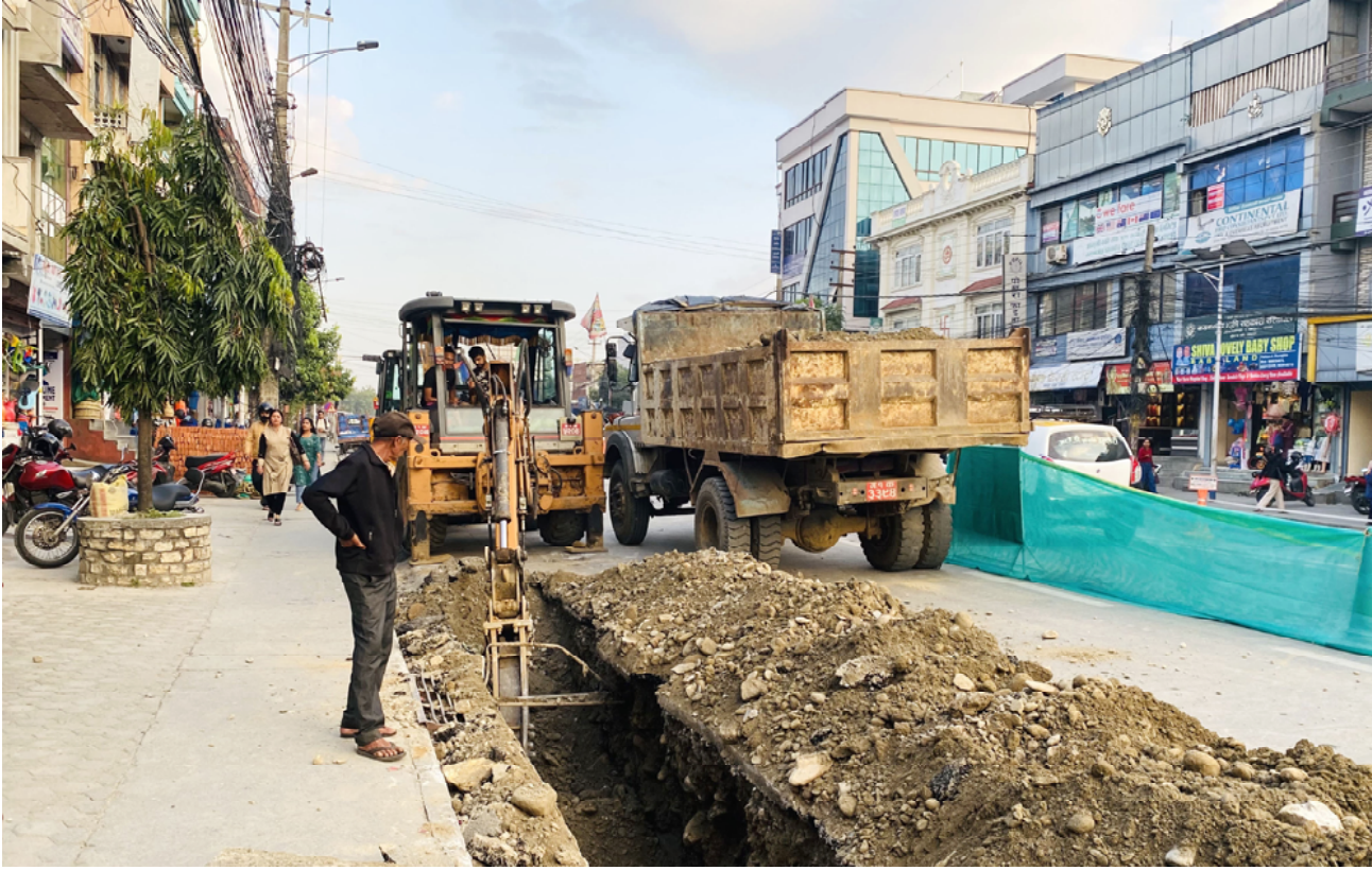
भूमिगत विद्युत तार : कास्कीको पोखरा महानगरपालिका-८ सभागृहचोकमा विद्युतीय तार भूमिगत गर्न उपकरणको सहायताले खाल्डो खन्दै मजदुर । नेपाल विद्युत् प्राधिकरणले पोखराको मुख्य सहर क्षेत्रमा तार भूमिगतको काम गरिरहेको छ । तस्बिर : राम थापा/रासस
