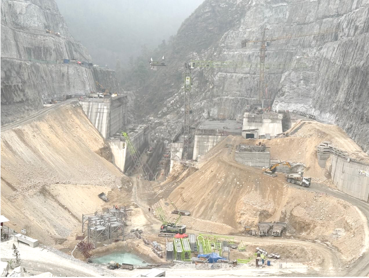
कामले गति लिंदै : तनहुँको व्यास नगरपालिका-५ र ऋषिङ गाउँपालिका-१ स्थित सेती नदीमा १४० मेगावट क्षमताको तनहुँ जलविद्युत आयोजनाको निर्माणधीन मुख्य बाँध । आयोजनाले बाँध निर्माण कार्यलाई तीब्रताका साथ अगाडि बढाइरहेको छ । तस्विर : भज्याङ
