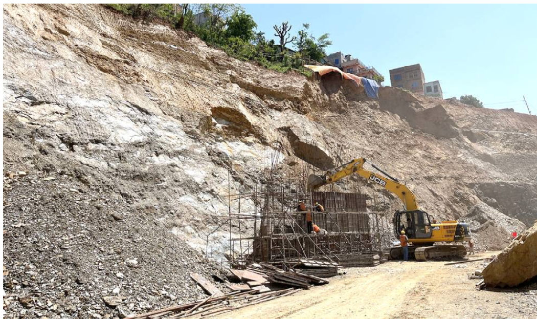
पहिरो रोकथाम : तनहुँको व्यास नगरपालिका-४ स्थित मादी पुलनजिक पहिरो रोकथामका लागि काम हुँदै । मादी पुलको पहुँच सडक निर्माणका लागि भित्ता काट्ने गरिँदा यहाँ पहिरोको जोखिम बढेको छ । तस्विर : भज्याङ
