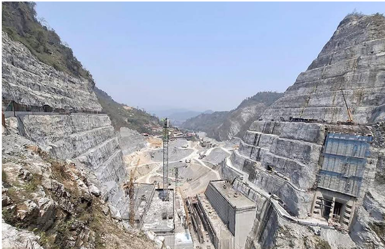
बाँध निर्माणस्थल: तनहुँको ऋषिङ गाउँपालिका-१ भापुटारमा निर्माणाधीन १४० मेगावाट क्षमताको तनहुँ जलविद्युत आयोजनाको प्याकेज १ अन्तर्गतको बाँध निर्माणस्थल ।
