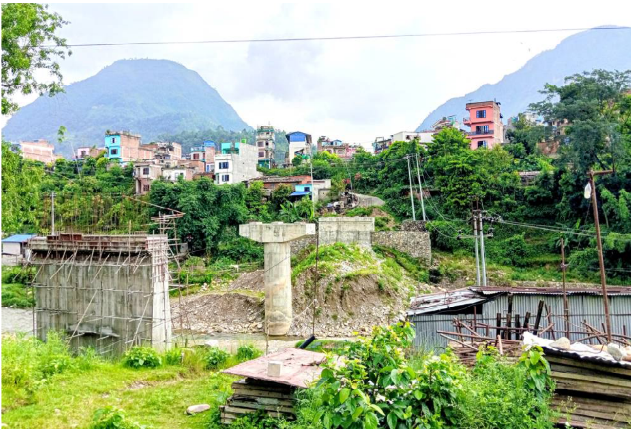
निर्माणाधीन मोटरेबल पुल : तनहुँको व्यास नगरपालिका-३ देउरालीनगर र व्यास नगरपालिका-१ भादगाउँ जोड्ने बुल्दीखोलामाथि निर्माणाधीन मोटरेबल पुल ।
