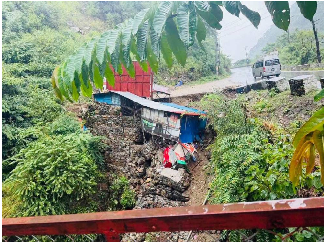
भाँसियो रेस्टुरेन्ट : पृथ्वी राजमार्गको मुग्लिन-आँबुखैरेनी सडक खण्ड अन्तर्गत तनहुँको आँबुखैरेनी गाउँपालिकाको ऐनापहरामा रहेको रेस्टुरेन्ट अविरल भर्रीका कारण शुक्रबार दिउँसो भासिएको छ । तस्विर : भञ्ज्याङ
